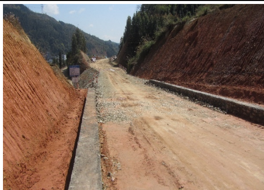
K33+800 右侧排水沟
