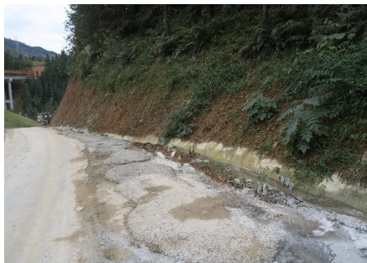
K32+600 生活区排水工程
