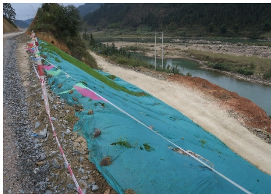
K58+600 左侧临时覆盖
